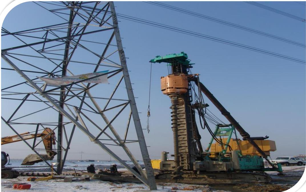
◇ 서초그랜드 아크로빌 신축현장, 분리형PRD, Ø400, L=23m(PHC PILE시공전경)◇
