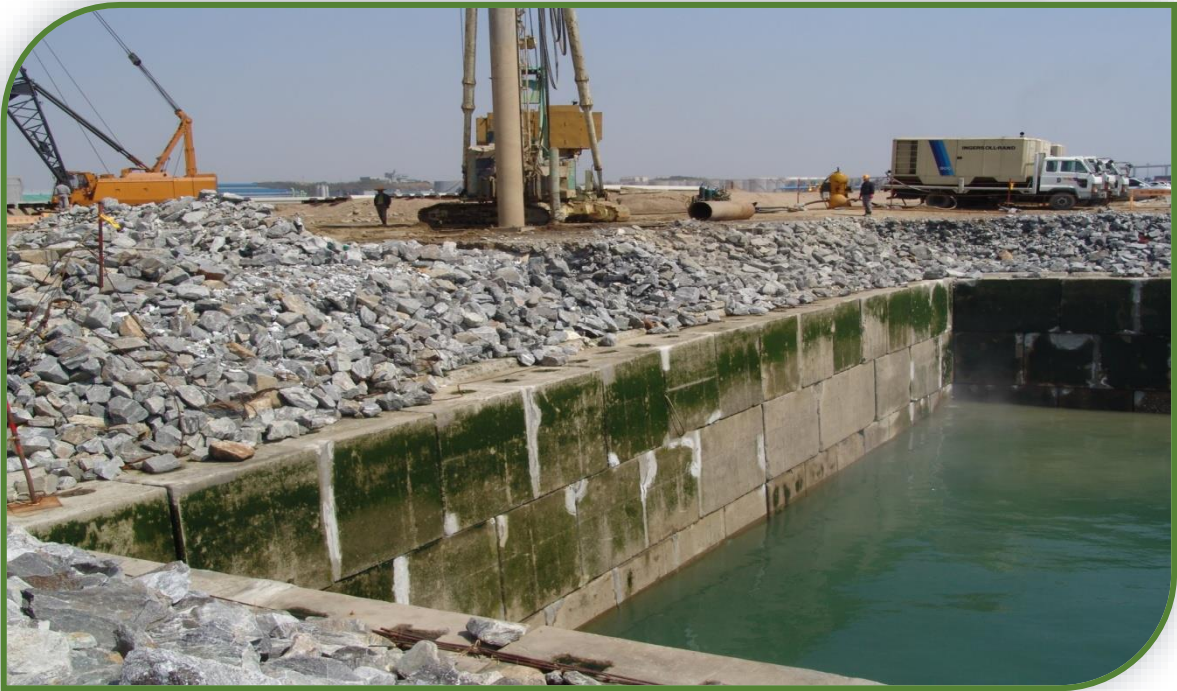
◇평택항 자동차전용부두 현장.PRD,Ø1000, L=19m(사석천공15m)◇ (사석매립층 PRD공법 S&C PILE 시공장면)
