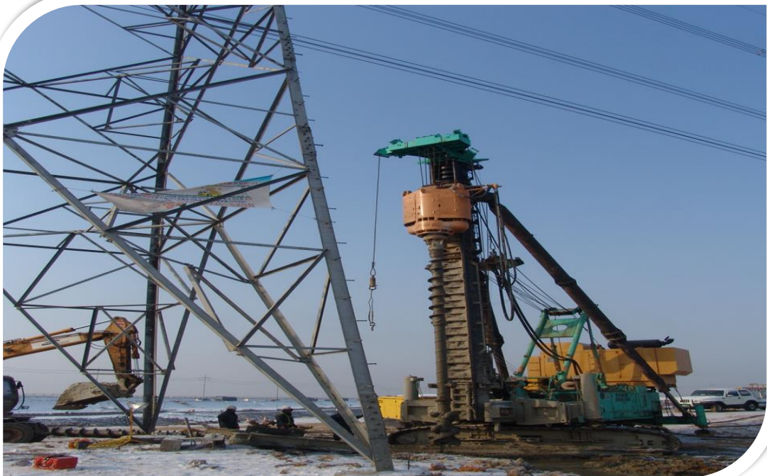
◇ 청라 아라뱃길현장,DCM,Ø1000, L=25m(DCM단축고압선 높이15m)◇ 〈전석,사석 구간 DCM 공법(1축작업)〉
