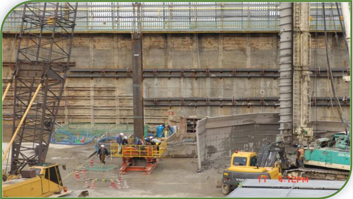
◇ 강남 삼성사옥현장,PRD,Ø1000, L=42m(25m토네이도함마 시공) ◇
