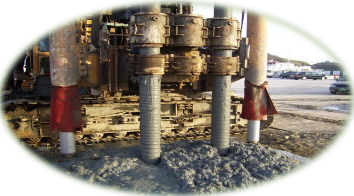
◇ 목포 북항 소형어선물 현장,DCM,Ø1000, L=30m(2축시공 전경)◇
